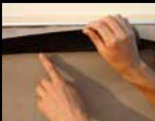
La partie supérieure des portes peut, si nécessaire, se transformer en prises d'air efficaces contre la condensation.
